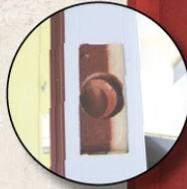
Coupe-froid flexible de nylon (aimanté ou à compression) pour une étanchéité accrue
